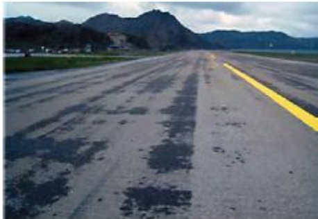
En utleggerbredde med kald masse, en OK
